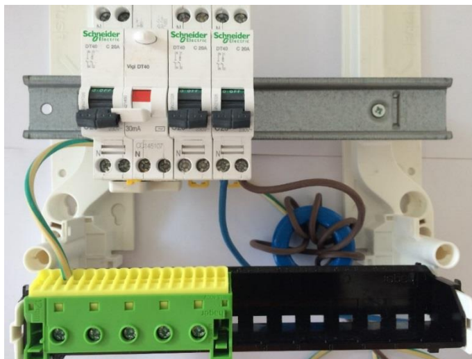
Afbeelding 8: gemonteerde ferrietringen in een driefasig groepenkast/meterkast
